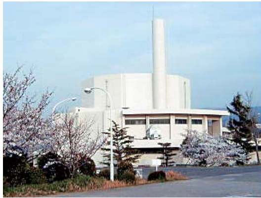
Photo 3-1. KUCA at the Reactor Research Institute. 写真3-1. 原子炉実験所・臨界実験装置 (KUCA).
